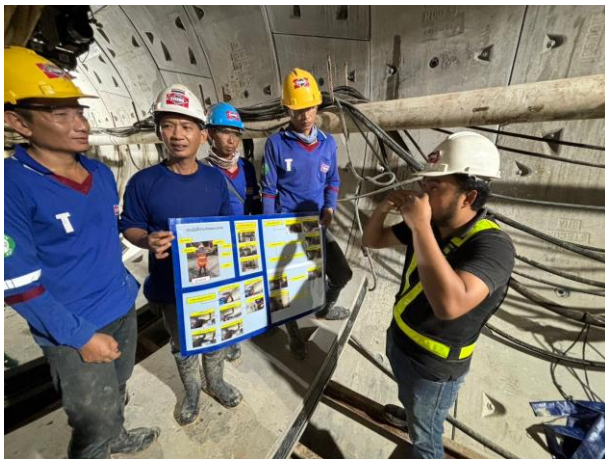
ผู้ควบคุมงานกำกับควบคุมดูแล ปฏิบัติงานตลอดเวลาการทำงาน
