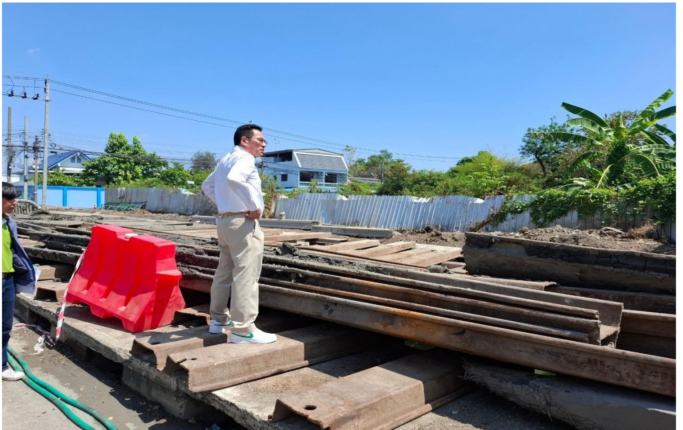
คณะอนุกรรมการการโยธาและผังเมือง ชุดที่ ๖ ลงพื้นที่ร่วมกับฝ่ายโยธา สำนักงานเขตหนองแขม และผู้เกี่ยวข้อง เพื่อตรวจสอบความคืบหน้าโครงการก่อสร้างเขื่อน ค.ล.ส. คลองก้านน้เทียน
