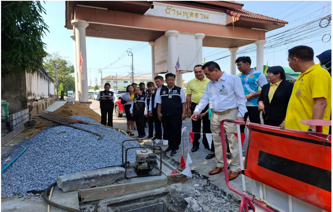
คณะกรรมการการโยธาและผังเมือง ชุดที่ ๖ ลงพื้นที่กับฝ่ายโยธา สำนักงานเขตหนองแขมเพื่อตรวจดู ความคืบหน้าก่อสร้างท่อระบายน้ำใหม่และคั่นหินทางเท้าบริเวณหน้าหมู่บ้านพุตตาน
