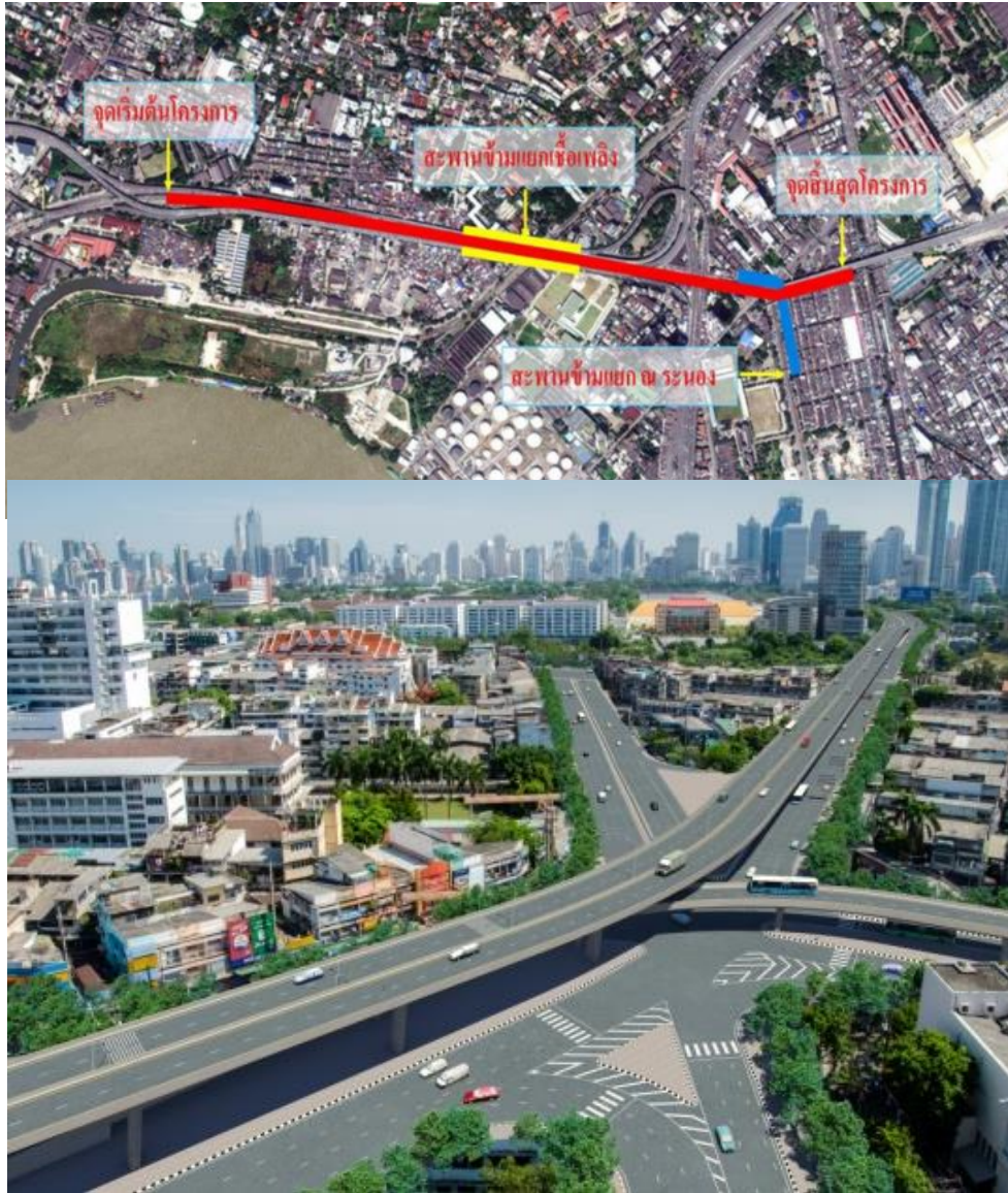
รูปภาพที่ ๓.๑๓ โครงการก่อสร้างสะพานข้ามแยก ณ ระนอง
