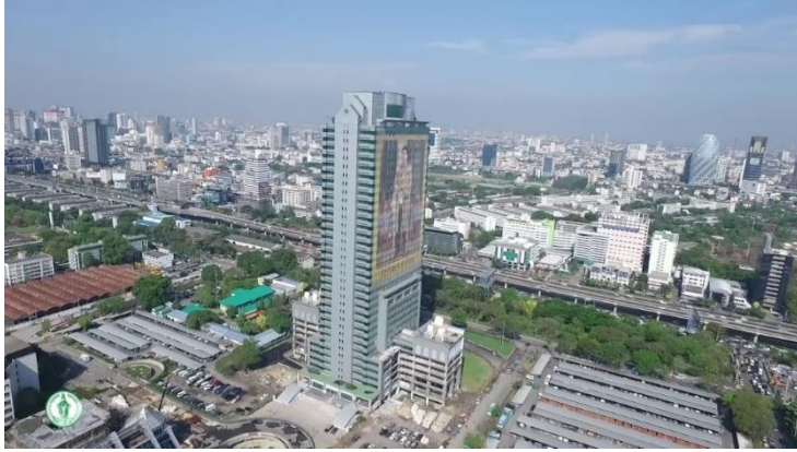
รูปภาพที่ ๓.๕ อาคารธานีพรีตน์ ศาลาว่าการกรุงเทพมหานคร ดินแดง ที่เสนอให้เป็นพื้นที่จัดตั้งศูนย์ควบคุมและสั่งการจราจรในพื้นที่กรุงเทพมหานคร และปริมณฑล (นนทบุรี ปทุมธานี ฉะเชิงเทรา สมุทรปราการ สมุทรสาคร และนครปฐม)
